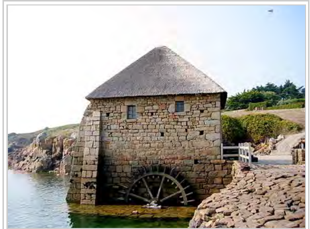
Tidal mill at l'île de Bréhat
